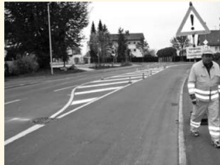
Das Bild zeigt Markierungsarbeiten in der Martin-Luther-Straße
